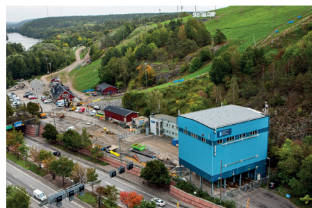
Vy Sicklaanläggningen mot Hammarbybacken
